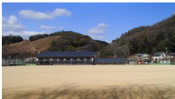
宝ヶ池公園少年スポーツ広場グラウンド改修工事
