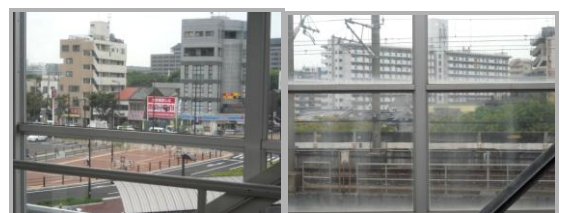
JRの駅舎ガラス 10年経過 (左:コート、右:未施工)
